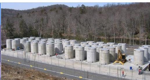
混凝土護箱 NAC-UMS 乾式貯存設施
