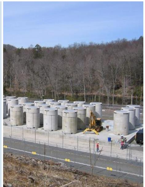
Connecticut Yankee 電廠 - 乾式貯存設施
