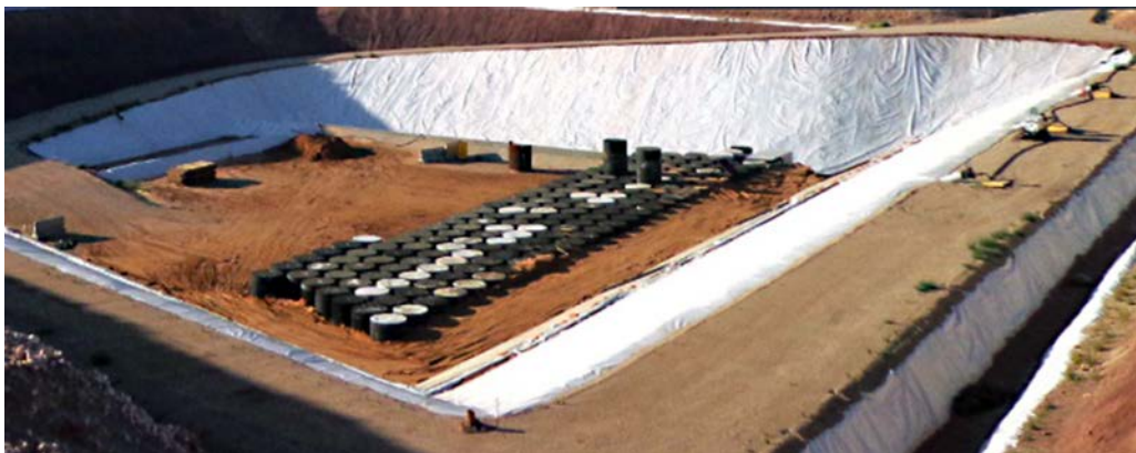
圖二 廢料控制專家公司 (WCS) 在安德魯斯郡的低階核廢料掩埋場 (取自 WCS 公司網站 ( http://www.wcstexas.com/ ))
